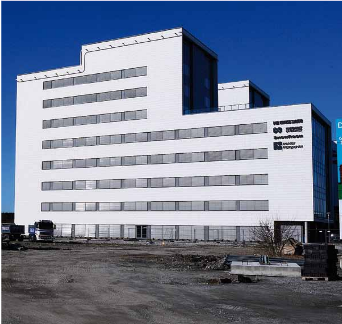
Med sine åtte etasjer har de nye høyhusene på Forus plass til rundt 175 personer. I det fremste bygget har blant andre Kruse-Smith flyttet inn. FOTO: JONAS HAARR FRIESTAD
